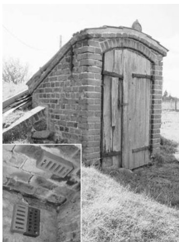
Ryc. 1. Wolnostojąca ziemianka z zawieszonymi ceglami dziurawkami
